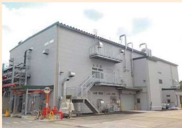
建設工事が完了した滋賀工場「新生産棟」
